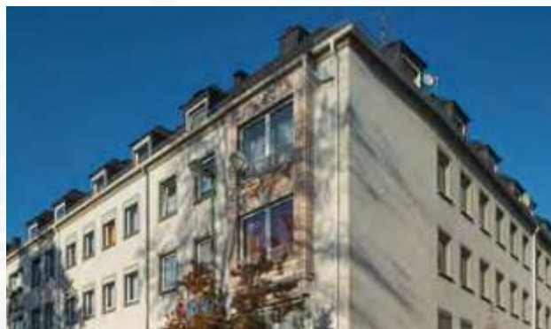
Siegen, Burgstrasse/Pfarrstrasse/Höhstrasse (ICD 8 R+)
